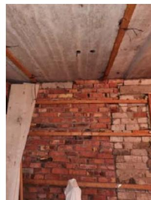
Плита перекрытия частично разрушена
